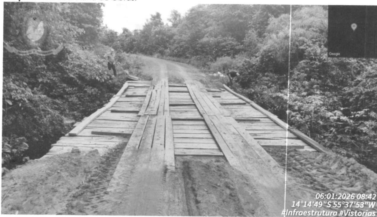
Figura 1-Ponte do Pantanalzinho (Larg. = 5m; Comp. = 13m)
